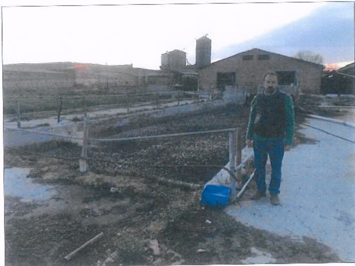
Foto 3: concimaia n. 2 per il solido dei suini e dei bovini; al centro si nota il pozzo nero per i liquami.
