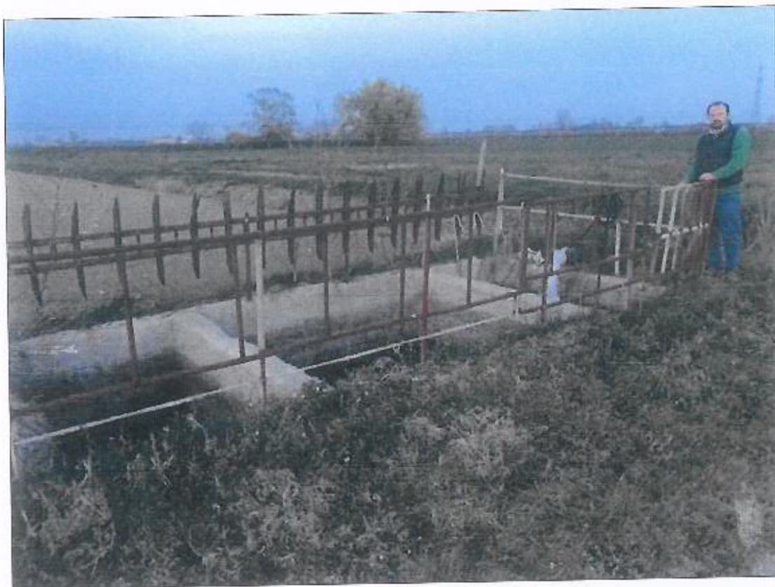
Foto 5: pozzo nero n. 3, per liquami sia bovini che suini, prima di andare ai lagoni in terra.
