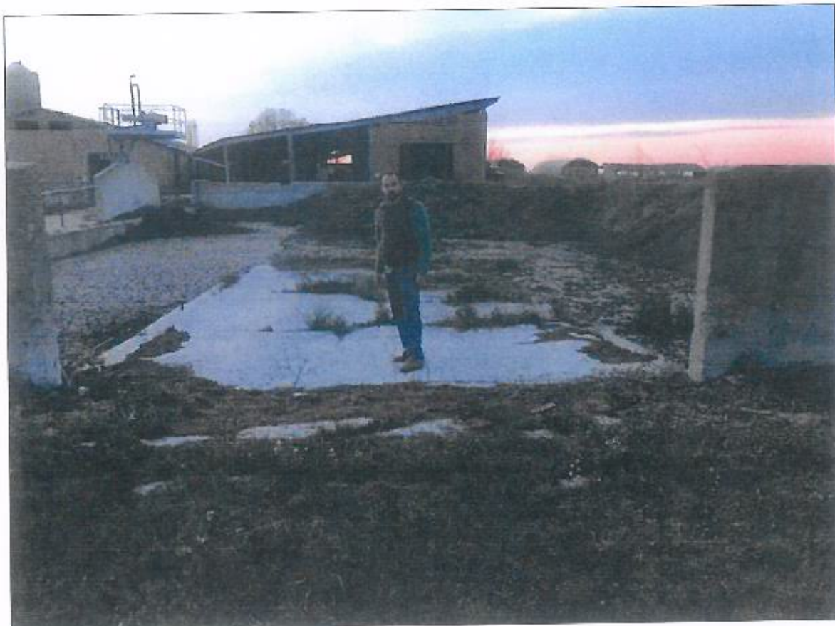
Foto 4: porzione più a nord della concimaia n. 2 per il solido dei suini e dei bovini.
