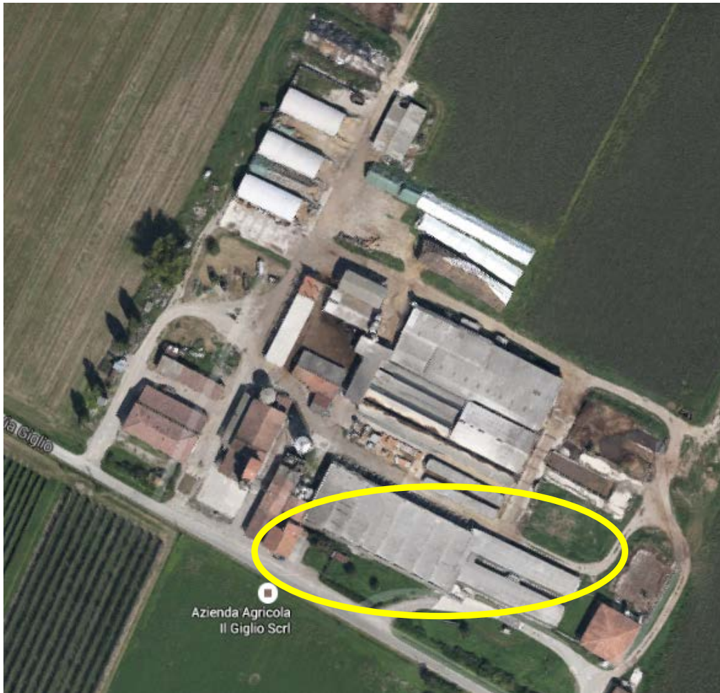
PORCILAIA ESISTENTE:: ubicato in Via Giglio n°6, prevista demolizione Identificato catastalmente: Fg. 17 P.IIa 139 - 146
