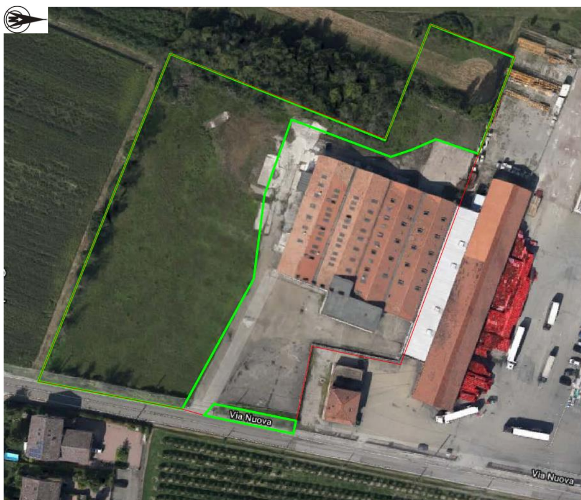
Figura 11 - Stato di fatto
