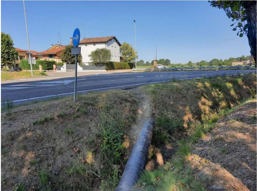
**Foto 7: Condotta utilizzata per attraversare il fossato esistente**
