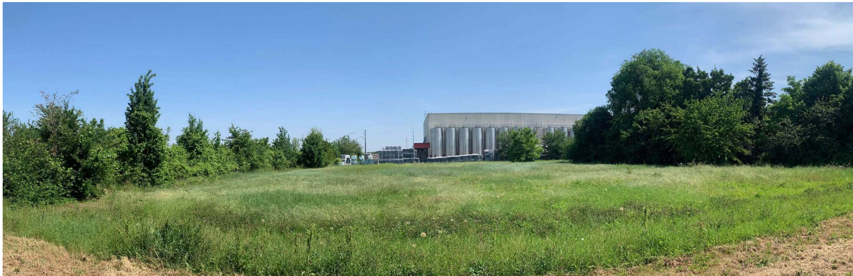
3 - Vista Panoramica dello stabilimento da via della Rosa Ovest
