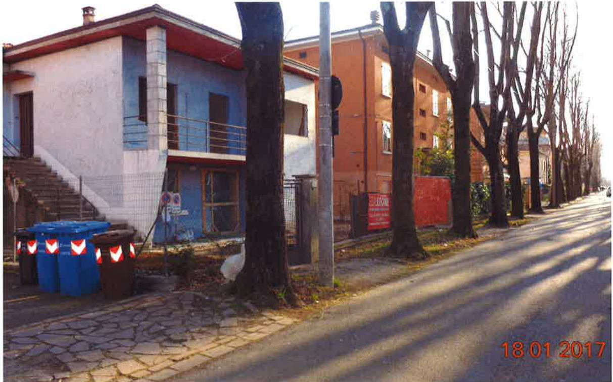
FOTO 5. Vista dell'ultimo tratto di marciapiede a nord-est del fabbricato in oggetto
