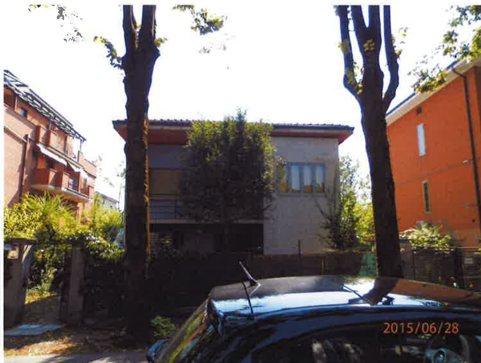
FOTO 1. Vista del prospetto nord-ovest
