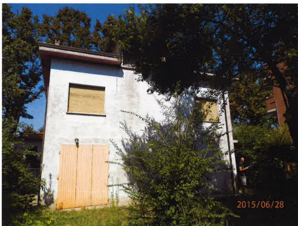
FOTO 2. Vista del prospetto sud-est
