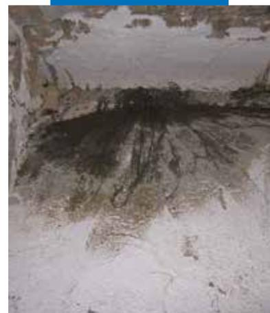
Connessione puntuale realizzata mediante MapeWrap B FIOCCO
