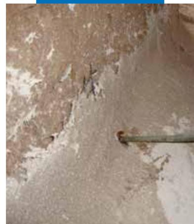
Inserimento di MapeWrap FIOCCO nel foro
