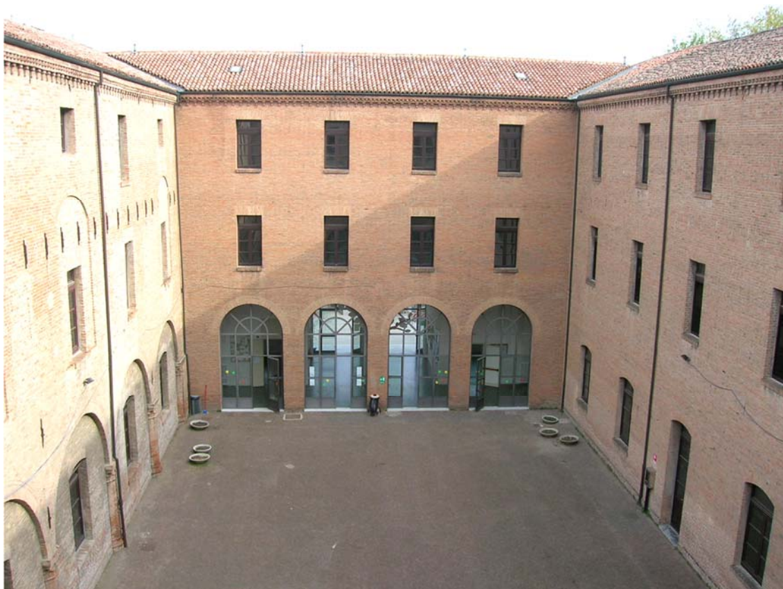
3 – Veduta del cortile interno lato est; in questa facciata del fabbricato, realizzata nel 1953-1954, è previsto l’innesto con la parziale copertura dello spazio polivalente.
