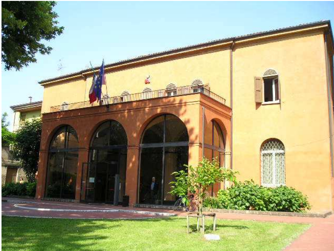
Veduta del Palazzo della Pieve, dal giardino interno, prima del sisma.
