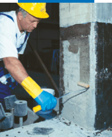
Applicazione della 1ª mano di MapeWrap Primer 1
