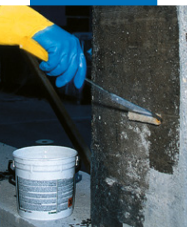
Applicazione della 2ª mano di MapeWrap Primer 1
