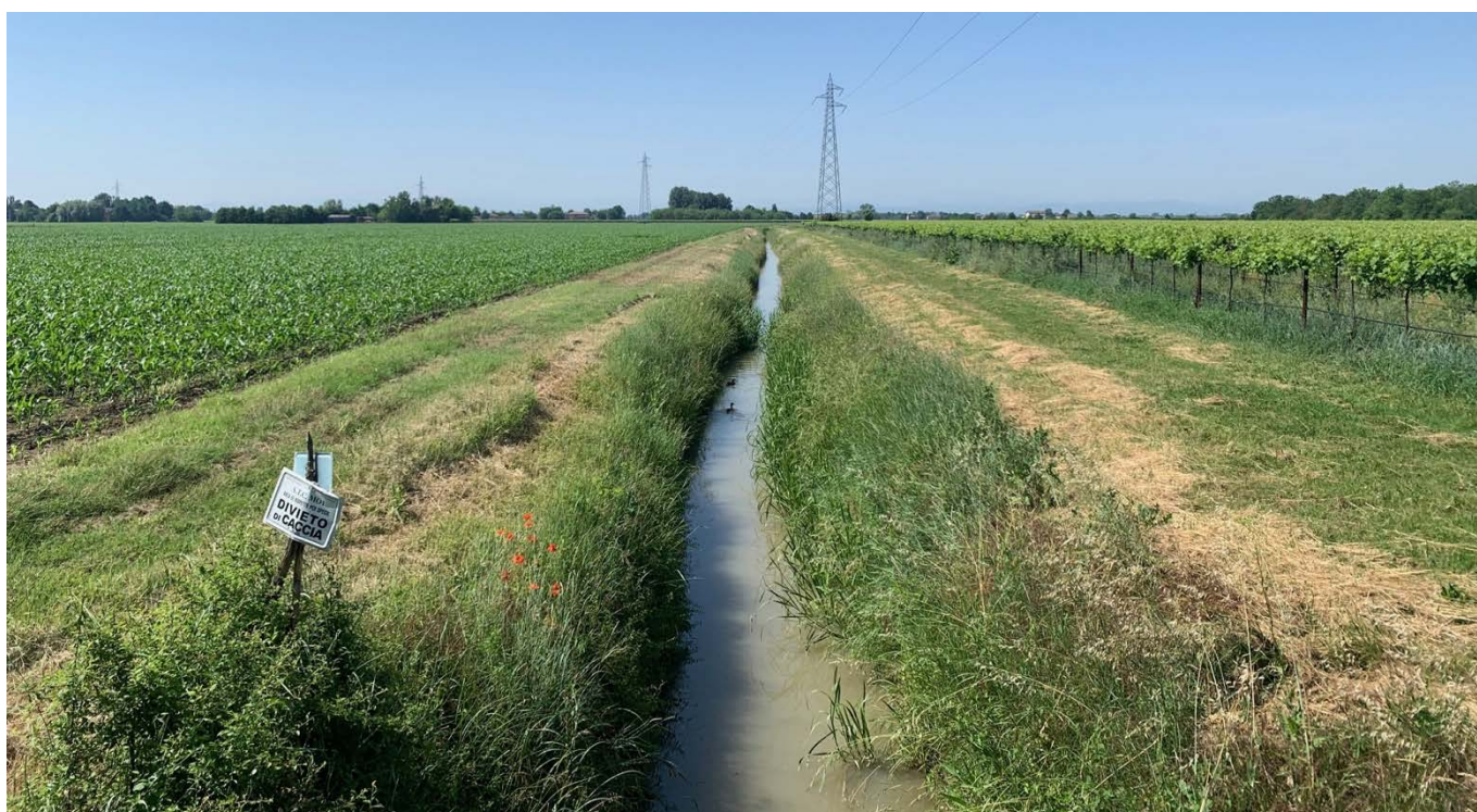
Tratto dello Scolo Fossa Nuova a sud della S.P. 486
