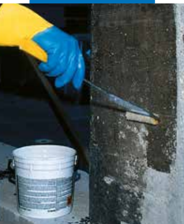
Stesura di MapeWrap 31 sullo strato di MapeWrap 11 (o MapeWrap 12) ancora fresco
