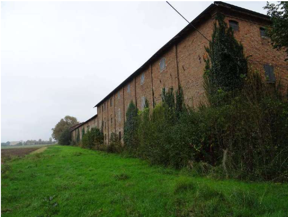
Carpi (MO), via Due Ponti – Area delle trincee 16-18
