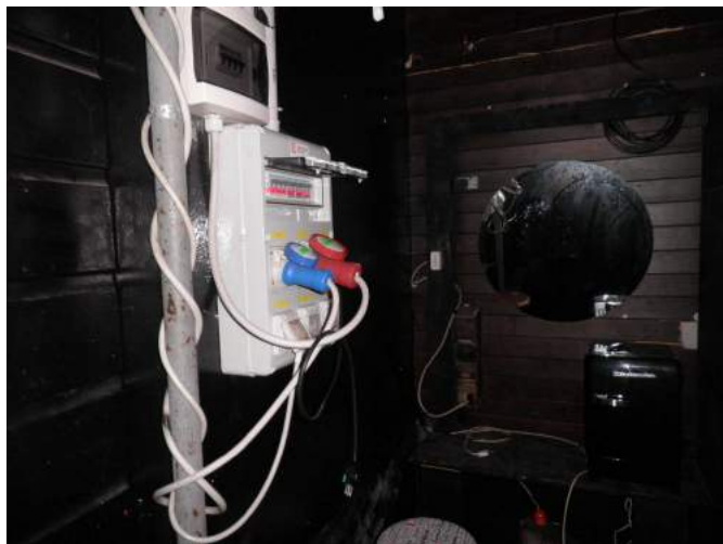
QUADRI ELETTRICI RETRO PALCO
