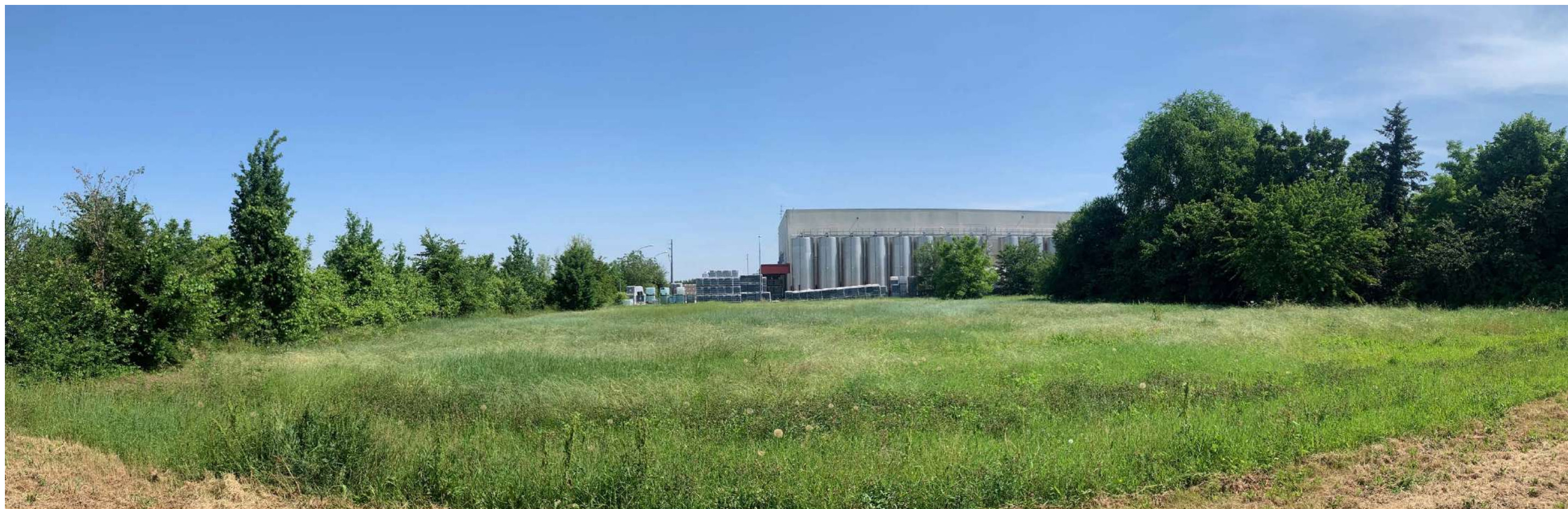
3 - Vista Panoramica dello stabilimento da via della Rosa Ovest
