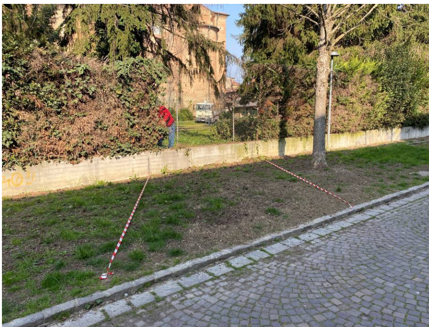
Fig. 1 – Zona di accesso all'area di cantiere ad ovest
