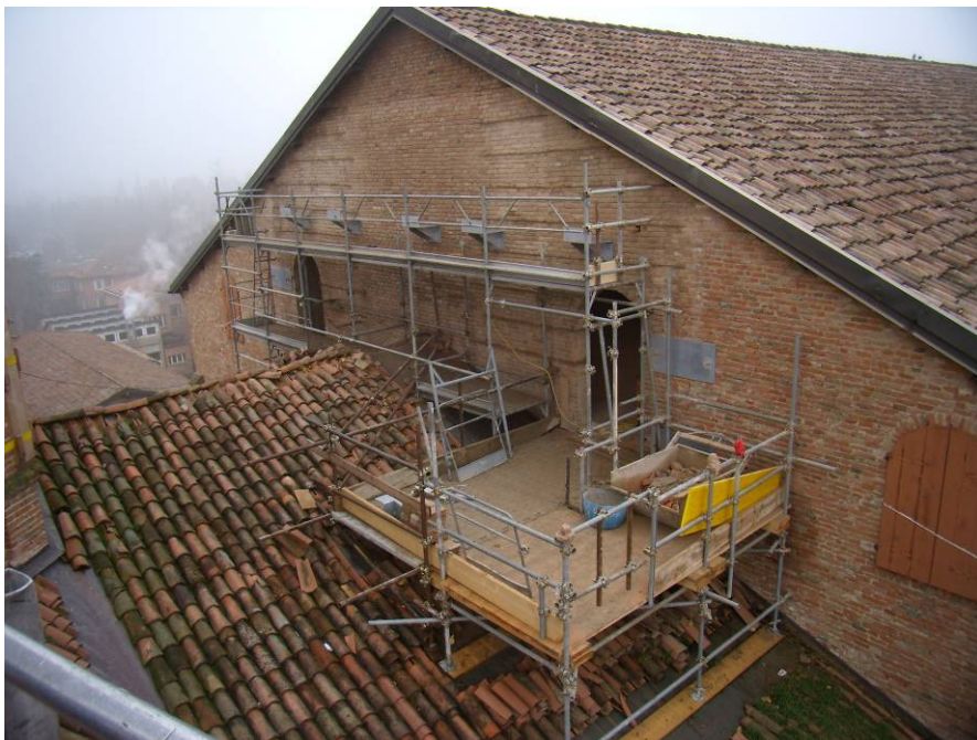
Fig. 24 – Il piano di carico rimasto da un precedente cantiere (prima della realizzazione dei ponteggi)
