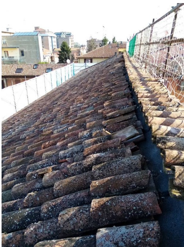
Fig. 11 – Parapetto nella parte di colmo del tetto del portico
