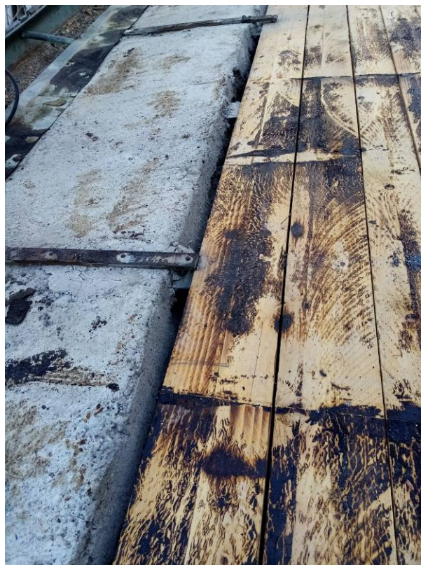
Fig. 9 – Dettaglio del tavolato sul cornicione di gronda
