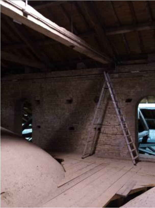
Fig. 18 – La muratura del sottotetto ed il piano di calpestio
