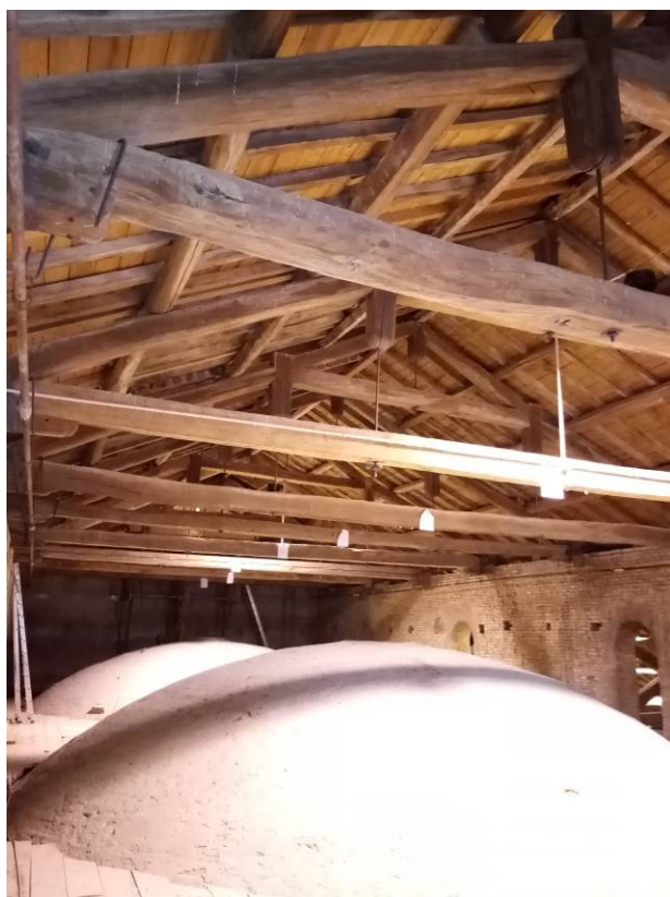
Fig. 12 – Vista del sottotetto della navata centrale
