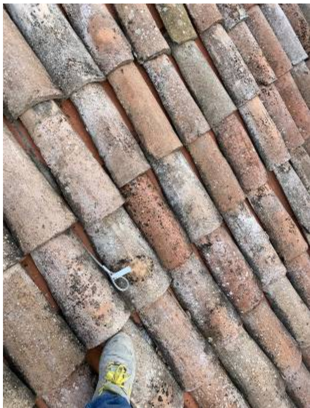
Fig. 22 , 23 – Ancoraggio tipo Flex ditta Livith (altro cantiere)
