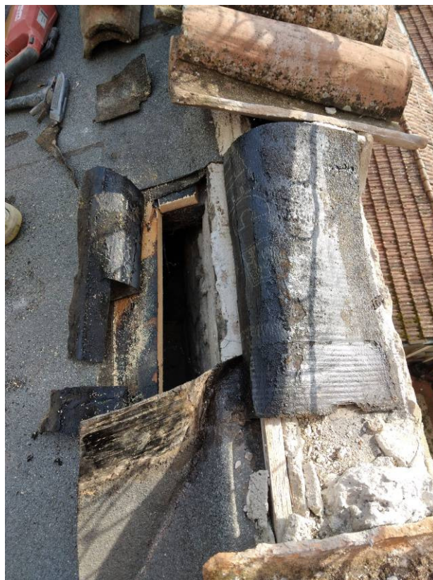
Fig. 7 – Muro nella parte di colmo del tetto del portico
