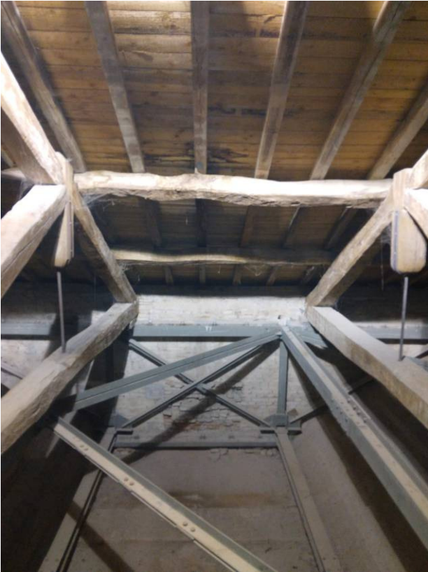
Fig. 14 – Struttura metallica piano di posa del piano di lavoro
