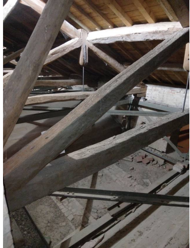
Fig. 15 – Estradosso delle volte della navata laterale
