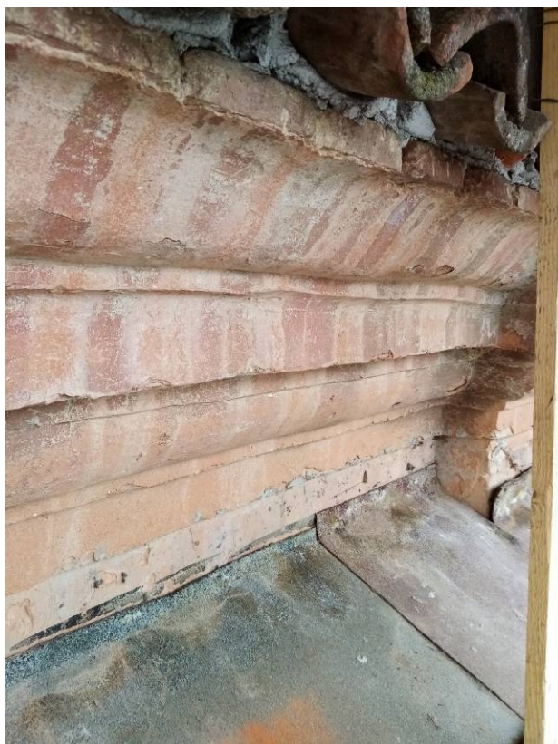
Fig. 6 – Cornicione di facciata sopra il tetto del portico
