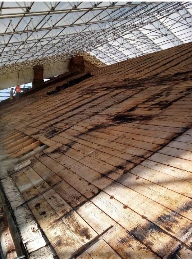
Fig. 16 – Vista del tavolato esistente della copertura delle navate
