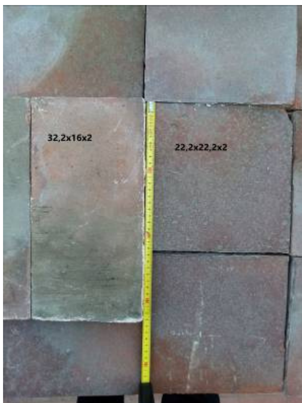
Fig. 4 – Le piastrelle rimosse
