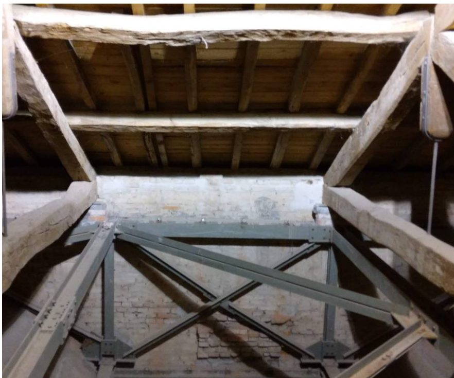
Fig. 21 – La struttura metallica delle navate laterali con le connessioni alla muratura perimetrale
