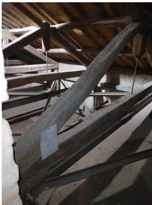
Fig. 13 – Sottotetto della navata laterale
