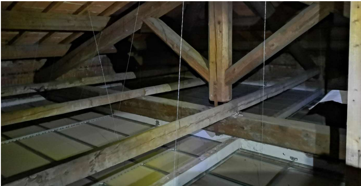
Immagine tramezze 1°P. da stabilizzare a seguito della rimozione del controsoffitto esistente
