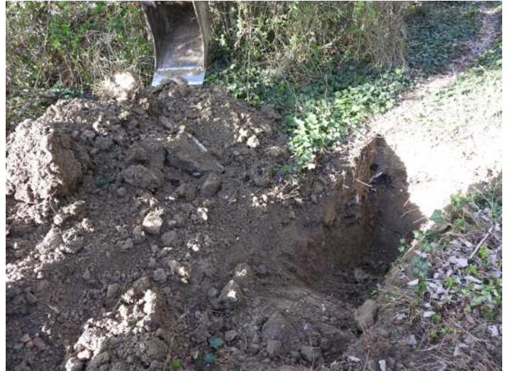
Foto n.20 – terreno sondaggio a 1.45 m
