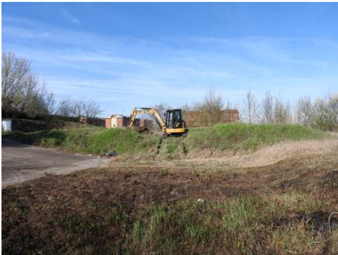
Foto n.37 – Panoramica duna con escavatore.
