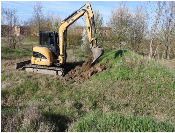
Foto n.35 – Panoramica duna con escavatore.
