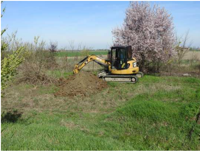
Foto n.31 – Panoramica sondaggio con escavatore.
