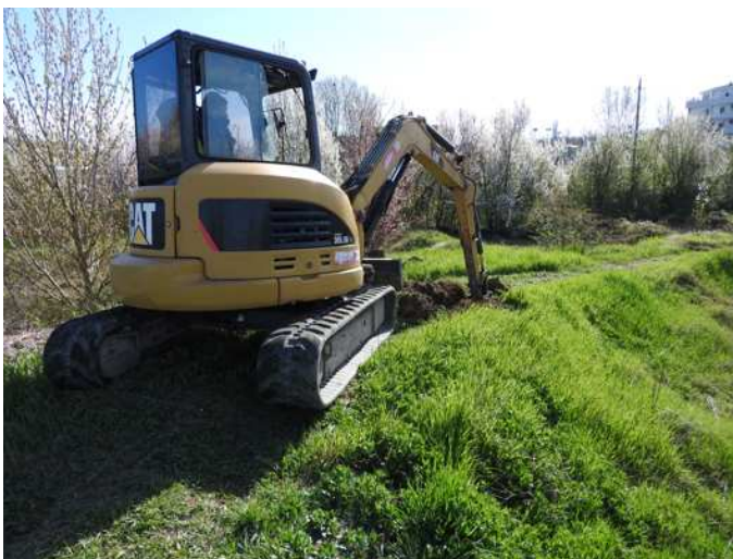
Foto n.27 – Panoramica escavatore e sondaggio.
