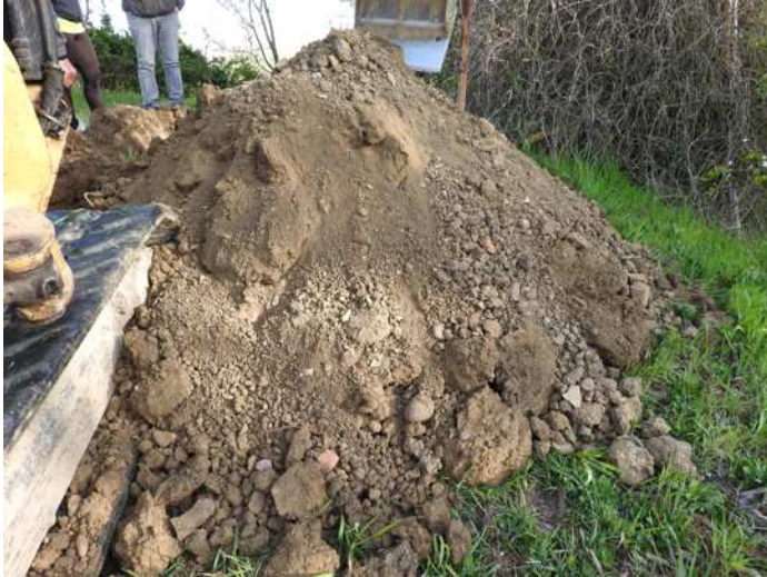
Foto n.19 – terreno sondaggio a -2.35 m
