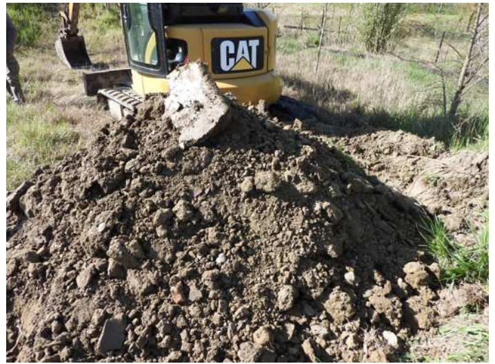
Foto n.36 – terreno sondaggio a -3.05 m
