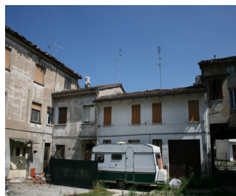
Foto da via Provinciale Mantova (cortile interno)
