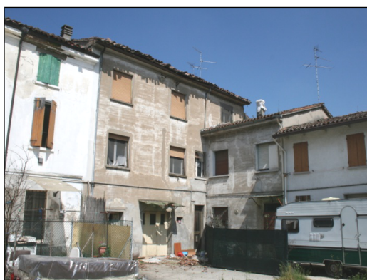
Foto da via Provinciale Mantova (cortile interno)
