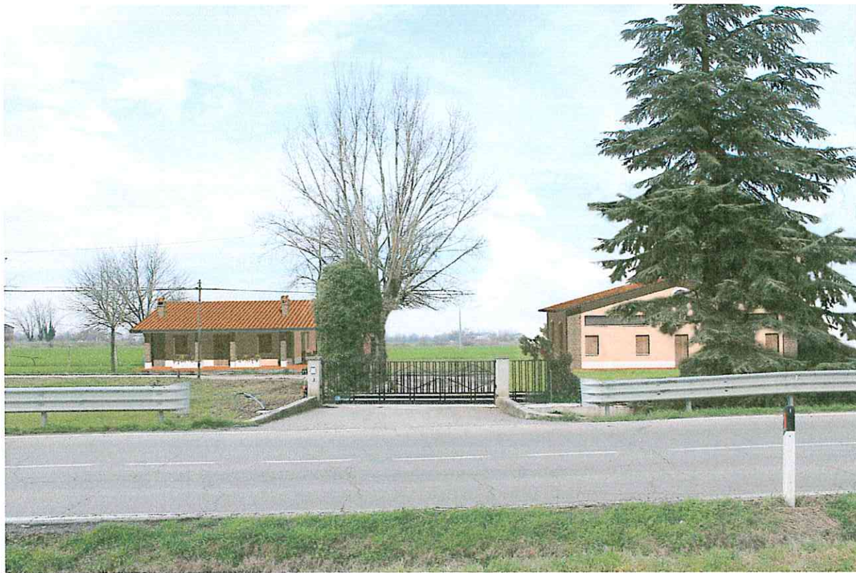
VISTA DA INGRESSO : DOPO
