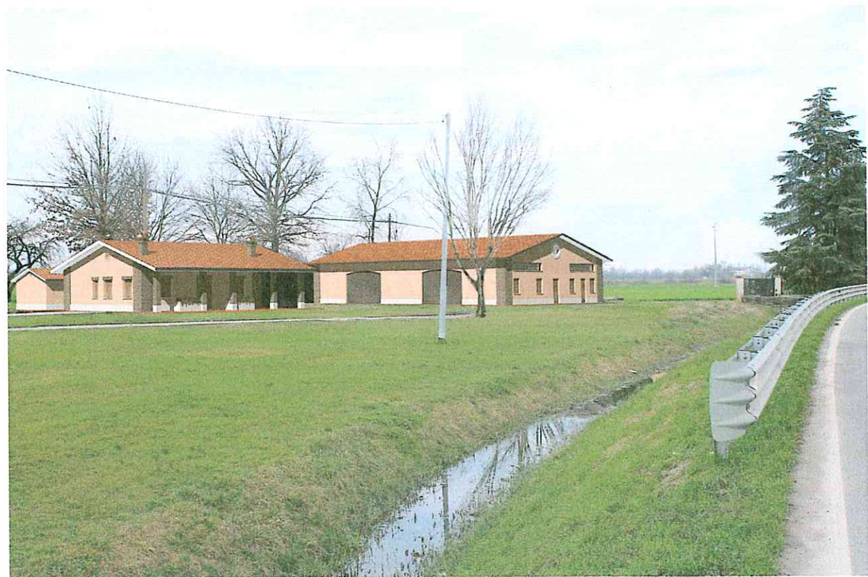
VISTA DA SUD : DOPO
