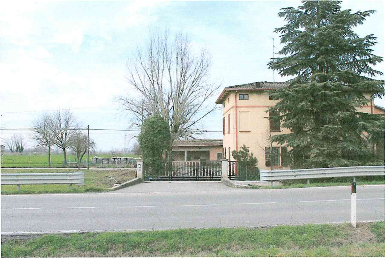
VISTA DA INGRESSO : PRIMA
