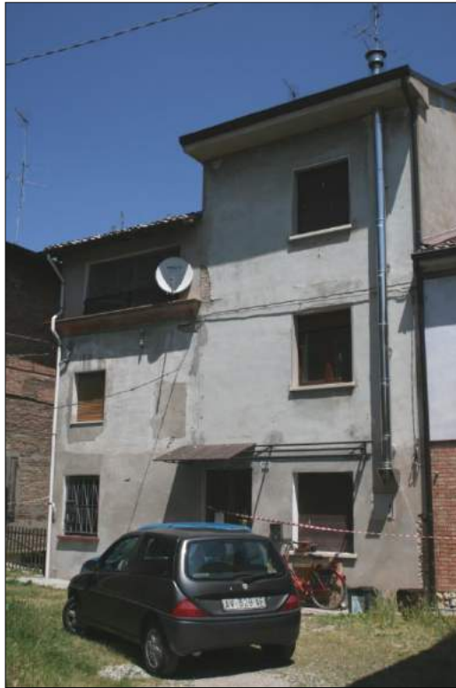
Foto da via Chiesa Sud (cortile interno)
