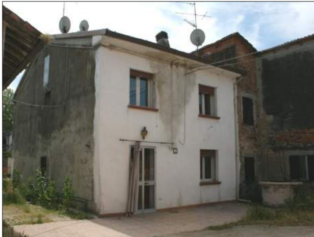
Foto da via Borgoferro (cortile interno)
