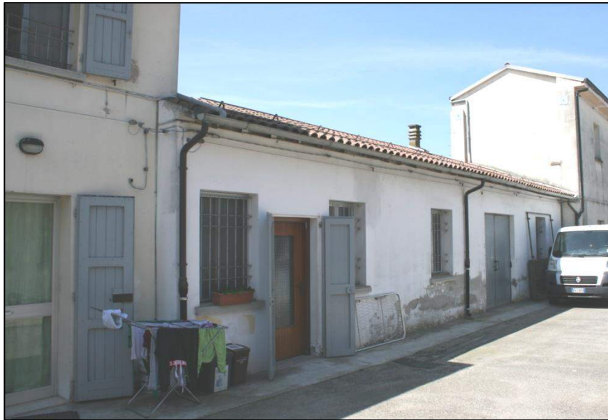
Foto da via Zoldi (cortile interno)
