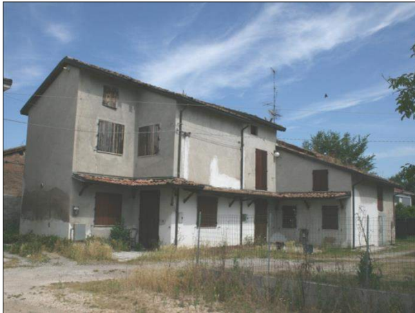
Foto da via Borgoferro (cortile interno)
