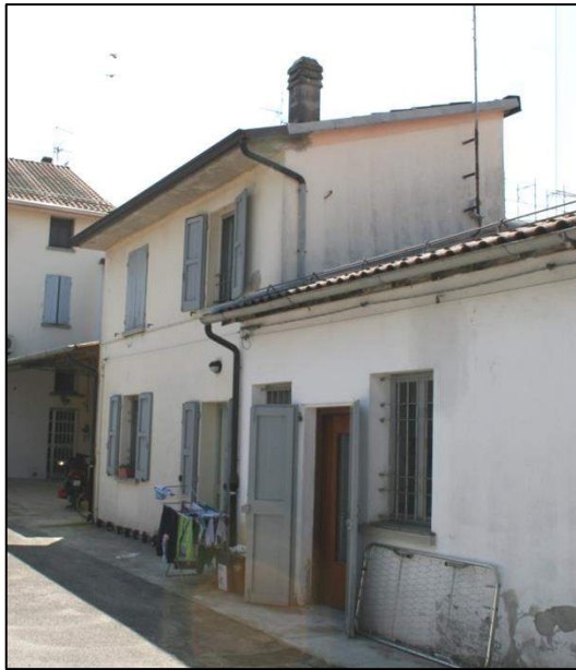
Foto da via Zoldi (cortile interno)
