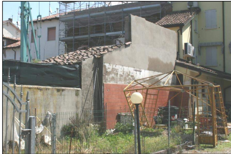
Foto da via Zoldi (cortile interno)
