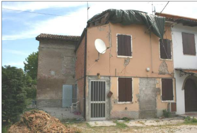
Foto da via Borgoferro (cortile interno)
