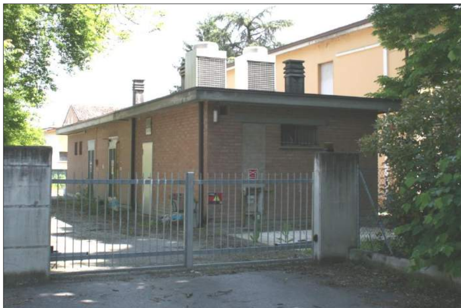
Foto da via De Amicis (cortile interno)
