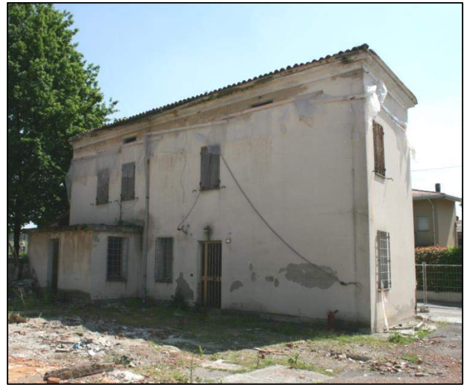
Foto da via De Amicis (cortile interno)
