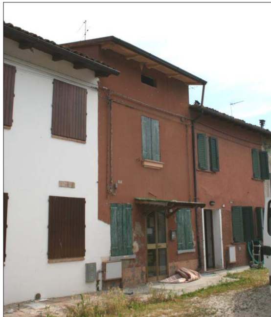
Foto da via Borgoferro (cortile interno)
