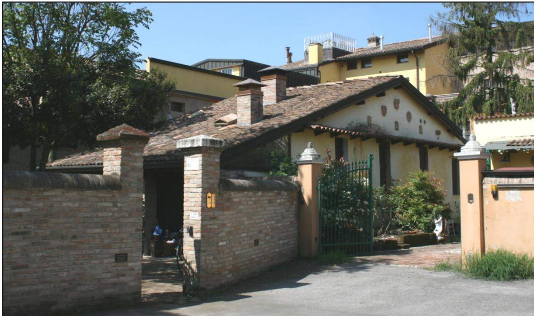
Foto da via De Amicis (cortile interno)
