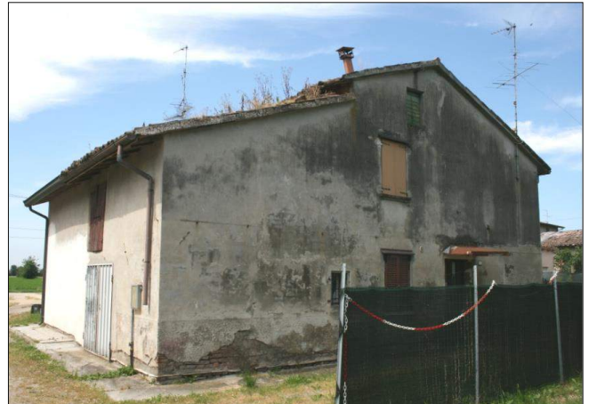
Foto da via Borgoferro (cortile interno)
