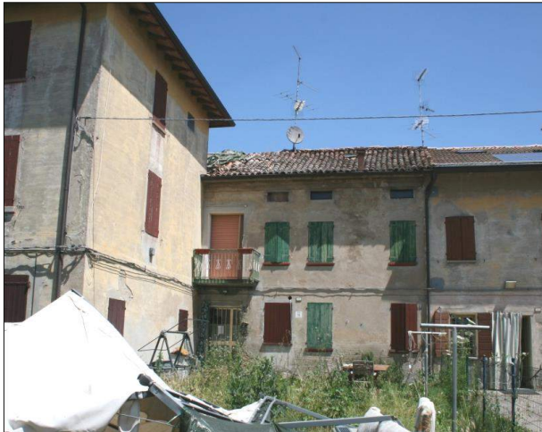
Foto da via Chiesa Nord (cortile interno)
