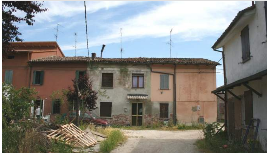
Foto da via Borgoferro (cortile interno)
