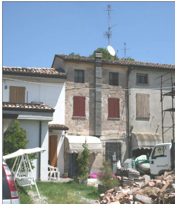
Foto da via Chiesa Sud (cortile interno)
