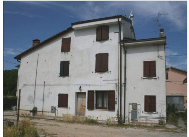
Foto da via Borgoferro (cortile interno)
