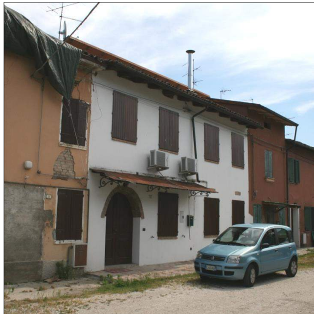
Foto da via Borgoferro (cortile interno)
