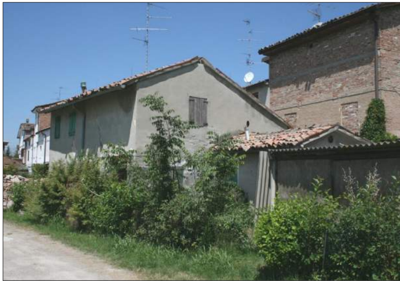
Foto da via Chiesa Sud (cortile interno)
