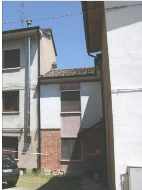
Foto da via Chiesa Sud (cortile interno)
