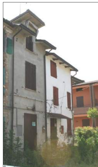
Foto da via S. Antonio (cortile interno)
