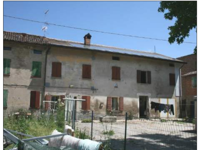
Foto da via Chiesa Nord (cortile interno)
