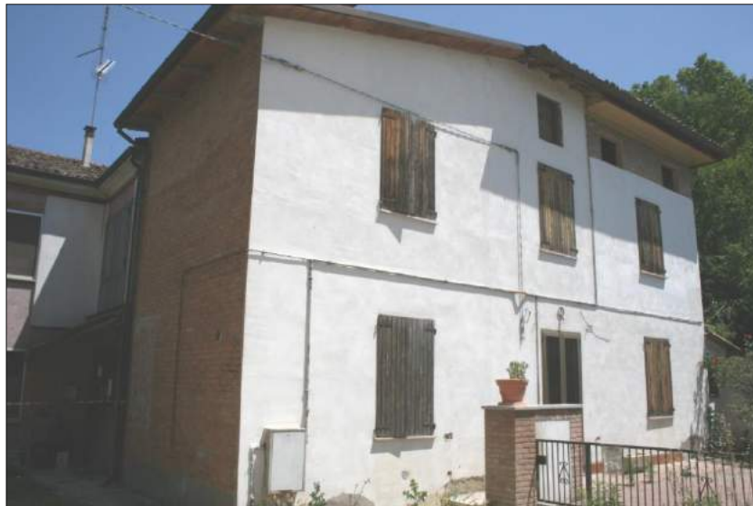
Foto da via Chiesa Sud (cortile interno)
