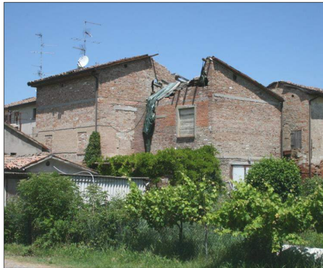
Foto da via Chiesa Sud (cortile interno)
