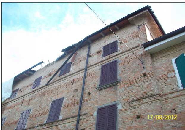
Particolare fronte nobile
