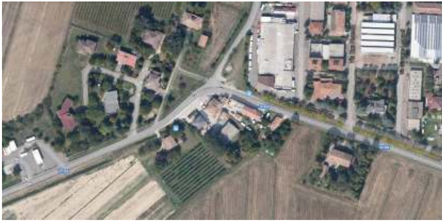
Vista aerea dopo il sisma
