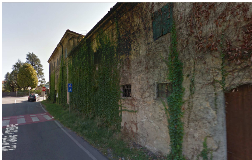
Foto da via Ponte Tintore verso via Provinciale Modena
